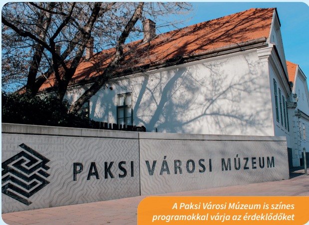
Csegey Dénes Kulturális Központ felújítása és bővítése
