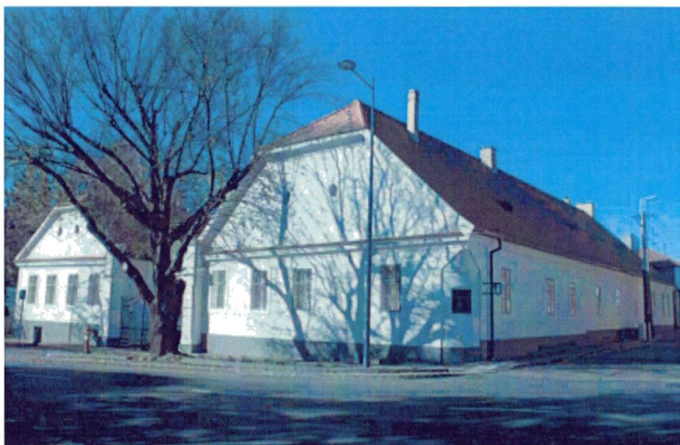
16. ábra: A Deák Ház épülete (nagy épület)
