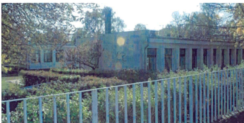
7. ábra: Kápolna utcai bölcsődeépület
